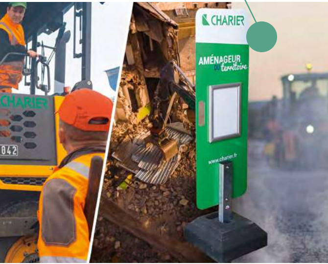
PANNEAU DE CHANTIER
